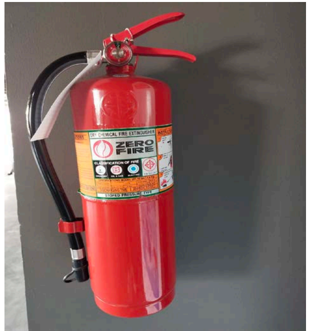
รูปที่ 2.6-4 ถังดับเพลิงมือถือขนาด 10 ปอนด์
