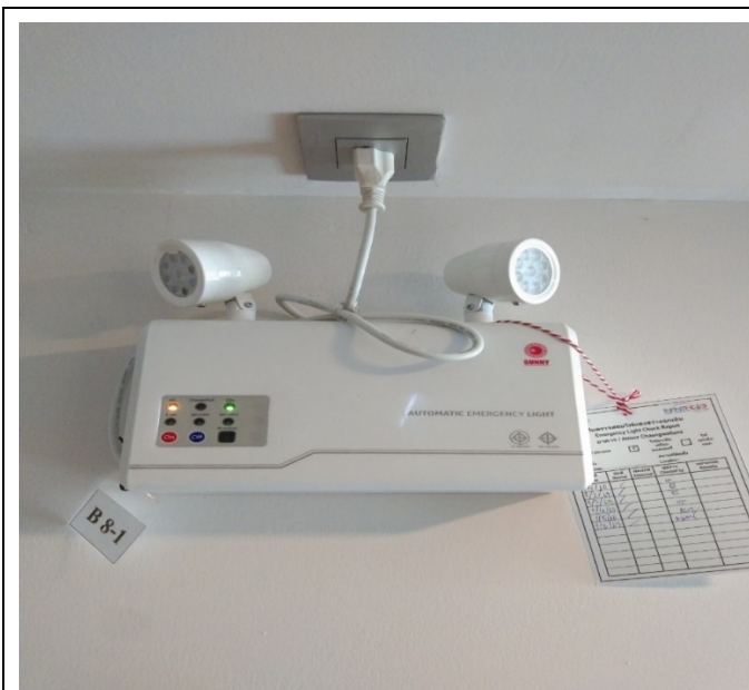
รูปที่ 2.6.3-3 ระบบไฟฟ้าส่องสว่างฉุกเฉิน
